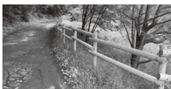
間伐材を使用した安全対策
