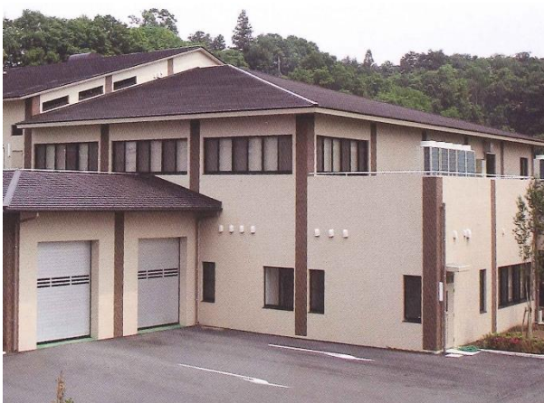
1. 汚泥再生処理センター 外観
