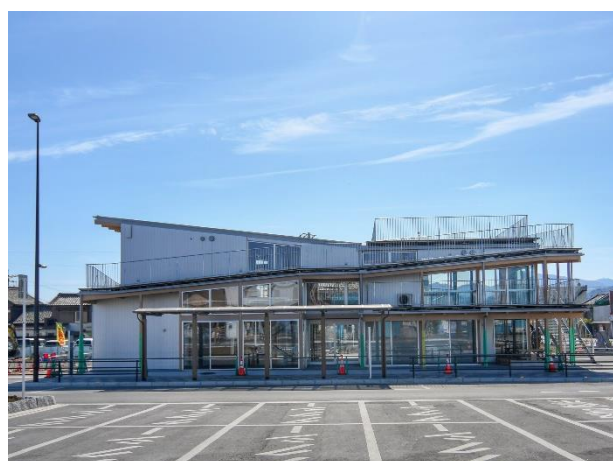
17. 寄居駅南口駅前拠点施設(Yotteco)
