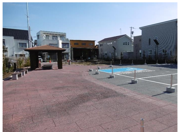
12. 寄居駅南口駅前広場(YORIBA)休憩施設
