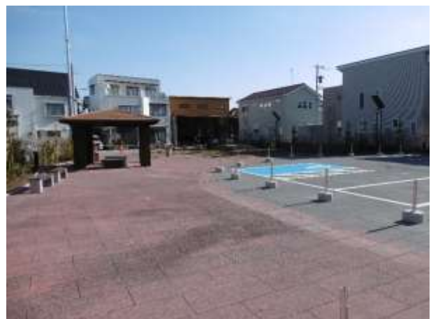
12. 寄居駅南口駅前広場(YORIBA)休憩施設
