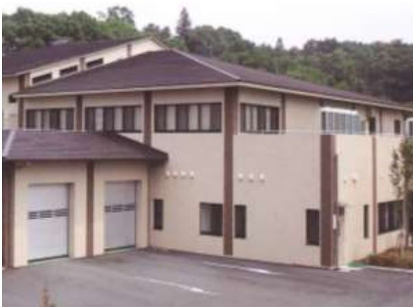
1. 汚泥再生処理センター 外観
