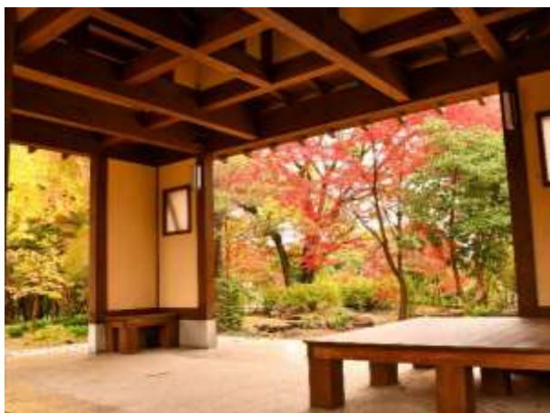
10. 雀宮公園休憩施設
