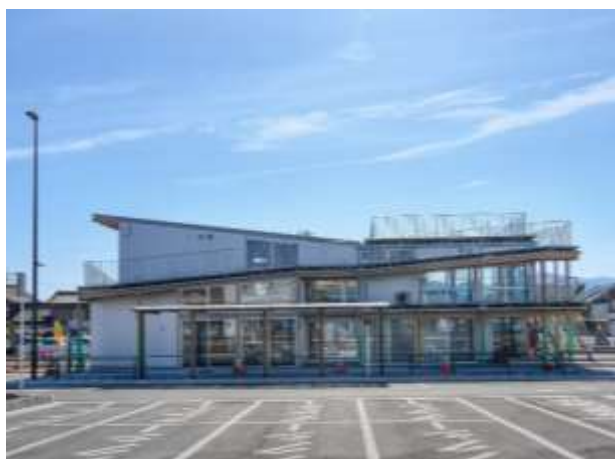
17. 寄居駅南口駅前拠点施設(Yotteco)
