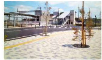
男衾駅西口外観(男衾駅周辺地区整備事業)
