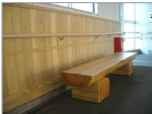
寄居駅自由通路の腰壁等に地元産木材を活用
